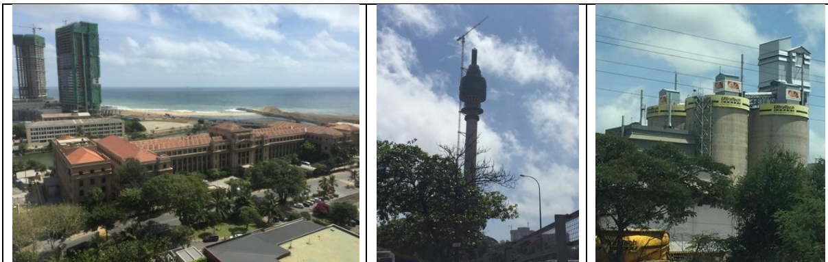
Beeindruckende Neubauten (Betonhochbau) in Colombo und ein Werk von UltratechCement (Indischer Zoz-Kunde) quasi an der Flughafenansahrt (rechtes Bild)
