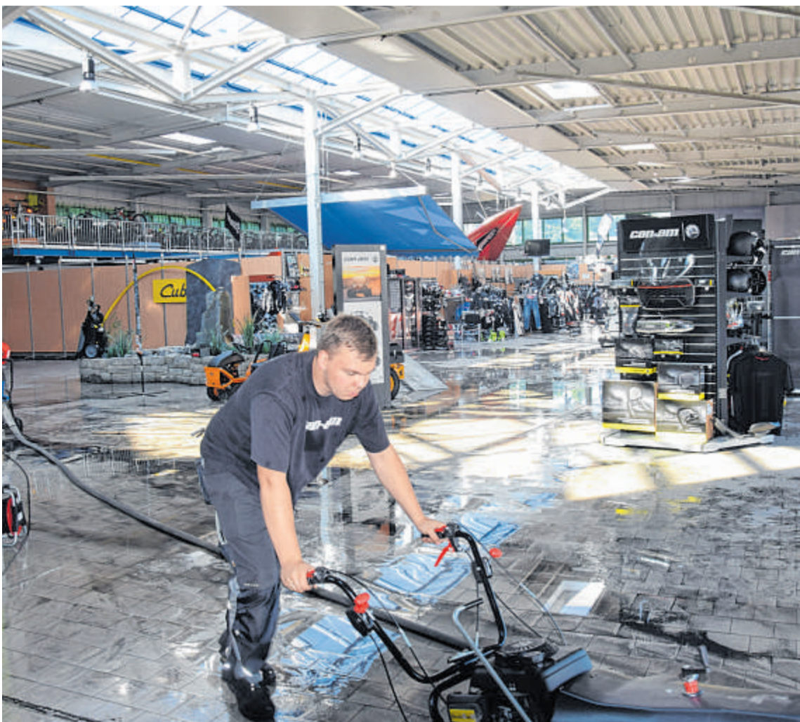
Die Aufräumarbeiten sind in vollem Gang. Das niedergebrannte Lager liefert ein Bild des Schreckens. Der Betrieb soll dennoch weitergeführt werden, sagt Armin Buchen, der geschäftsführende Gesellschafter der Buchens GmbH in Dahl/Friedrichsthal.
